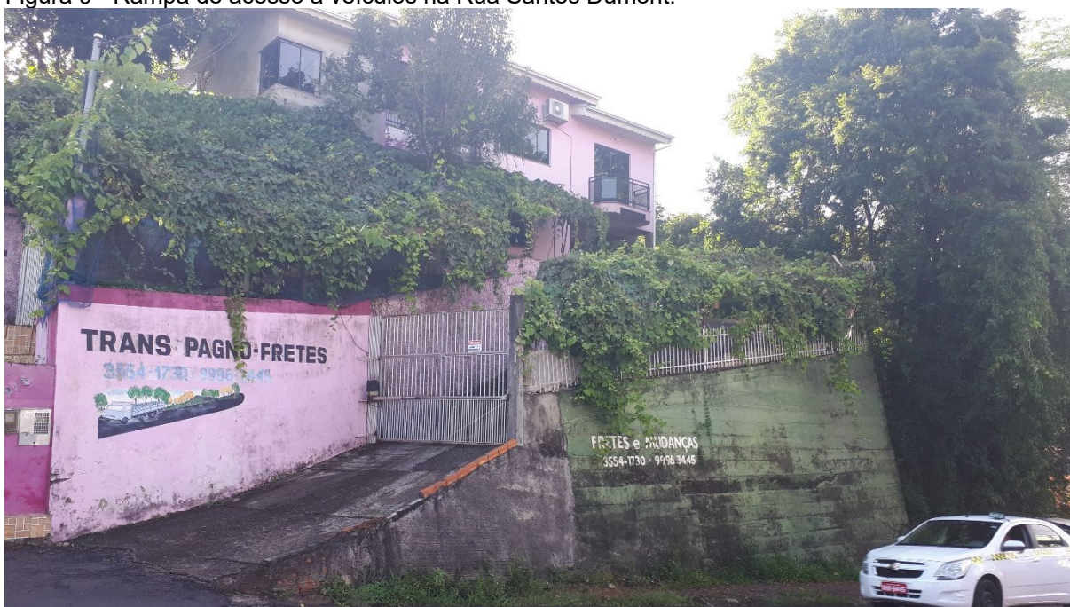
Figura 9 - Rampa de acesso a veículos na Rua Santos Dumont.
