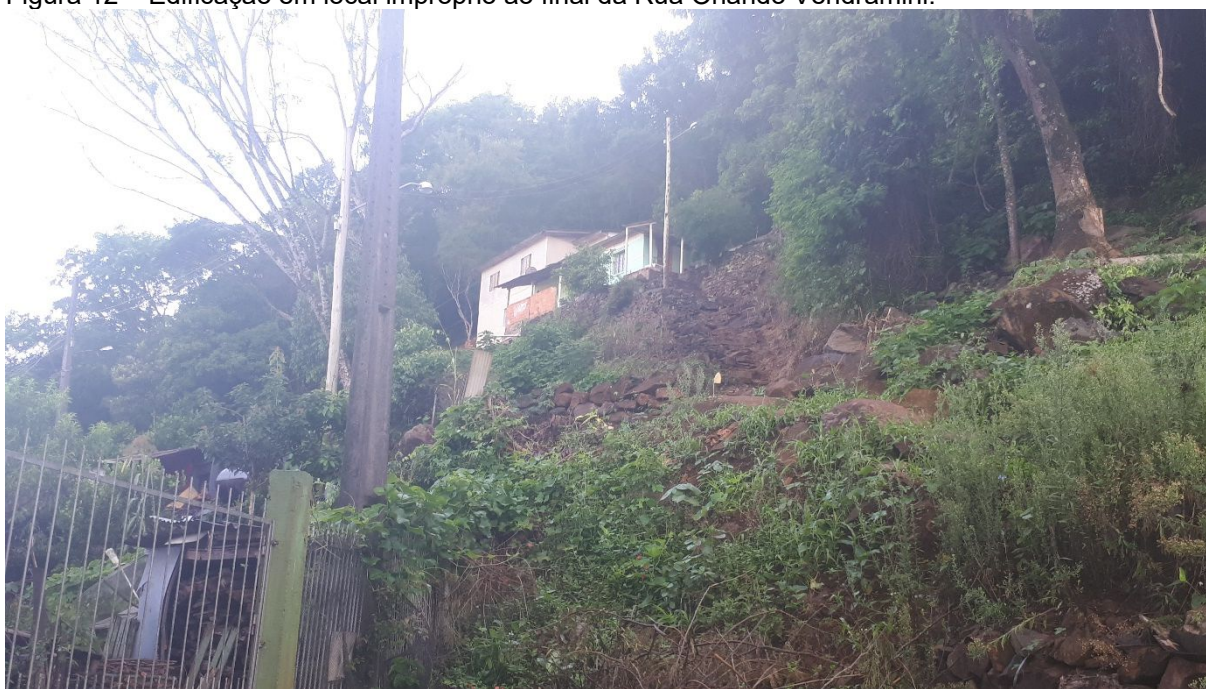
Figura 12 – Edificação em local impróprio ao final da Rua Orlando Vendramini.
