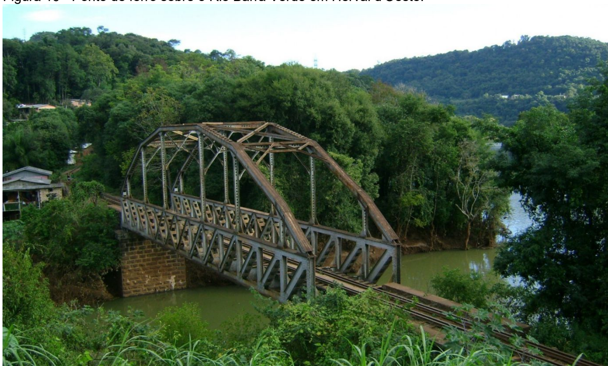
Figura 16 - Ponte de ferro sobre o Rio Barra Verde em Herval d'Oeste.
