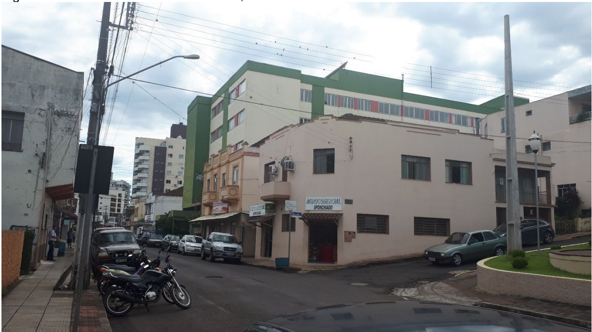
Figura 13 - Edifício na Rua Nereu Ramos, Centro.
