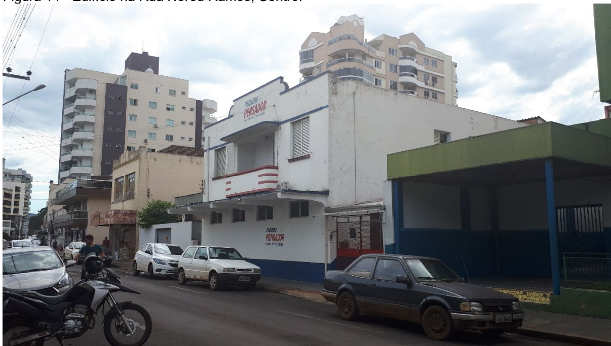
Figura 14 - Edifício na Rua Nereu Ramos, Centro.
